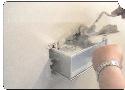
3 Vollständig in Wand-/Deckentiefe einmörteln.
