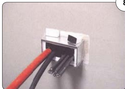
8 Stopfen wird mit Folie nach außen in die Restöffnung eingesetzt. Reste können z.B. zur Abdichtung von Leerrohren genutzt werden.
