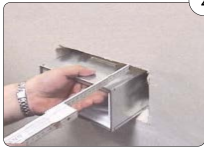
2 Box in Öffnung einsetzen, maximaler Überstand: 8,5 cm. (Decke: 6 cm)
