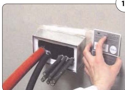
11 Nach Installation wird das ausgefüllte Güteschild neben der Abschottung dauerhaft und gut sichtbar befestigt.
