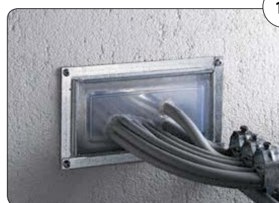
12 Bei Einbau in Leichtbauwände wird zusätzlich beidseitig ein 4-teiliger Rahmen um die Box gelegt und mit der Wand verschraubt.
