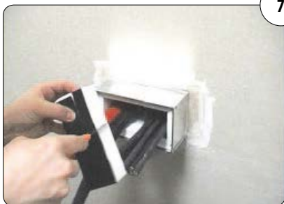
7 Nach Kabelinstallation werden EasyFoam-Stopfen einige mm größer als benötigt zugeschnitten, damit sie fest in der Öffnung sitzen.
