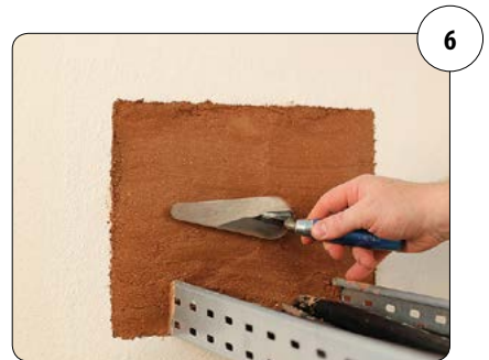
6 Abschließend die Oberfläche glätten.
