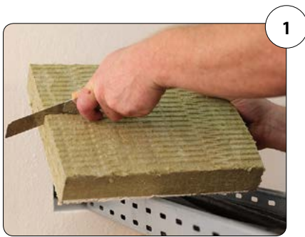
1 ... verlorene Schalung aus Brandschutzplatten RP-15 mittels Messer an die Durchbruchgröße anpassen
