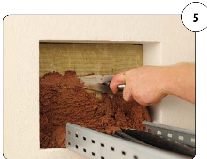
5 ... oder Spachtel in den Durchbruch einbringen. Auch auf die Räume zwischen den Kabel achten.
