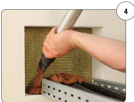
4 Fertig gemischten bst-Mörtel mittels Mörtelpumpe ...
