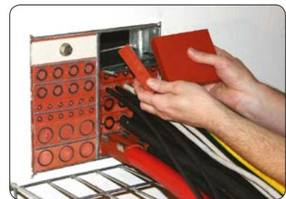
bst-Füllmodule (Filler Block „FB“) und Füllmodulplatten (Multi Filler Block „MFB“) stehen in folgenden Größen zur Verfügung:
