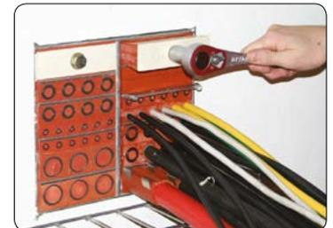
Verdichtung mittels Keildichtung KS-120
