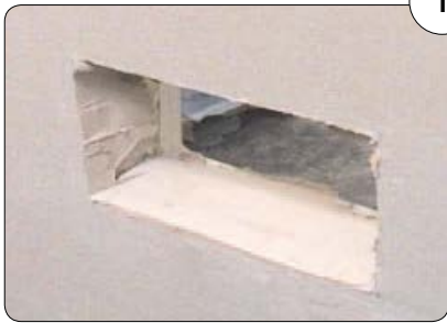
1 Gips- od. Mörtelbett in Öffnung einbringen
