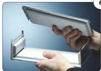
6 Boxen werden auseinander genommen, um die Kabel gelegt und wie beschrieben eingemörtelt.
