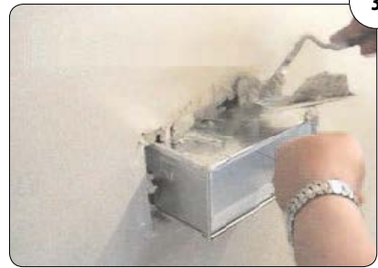
3 Vollständig in Wand-/Deckentiefe einmörteln.
