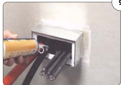
9 Danach werden alle Restöffnungen mit dauerelastischen Dichtstoff, z.B. Silikon, rauchdicht verschlossen.
