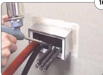
10 Alternativ zum Silikon kann auch EasyFoam-Brand-schutzmontageschaum verwendet werden.
