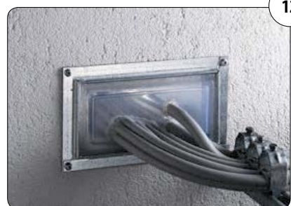
12 Bei Einbau in Leichtbauwände wird zusätzlich beidseitig ein 4-teiliger Rahmen um die Box gelegt und mit der Wand verschraubt.
