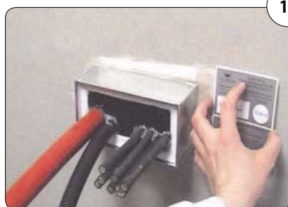
11 Nach Installation wird das ausgefüllte Güteschild neben der Abschottung dauerhaft und gut sichtbar befestigt.
